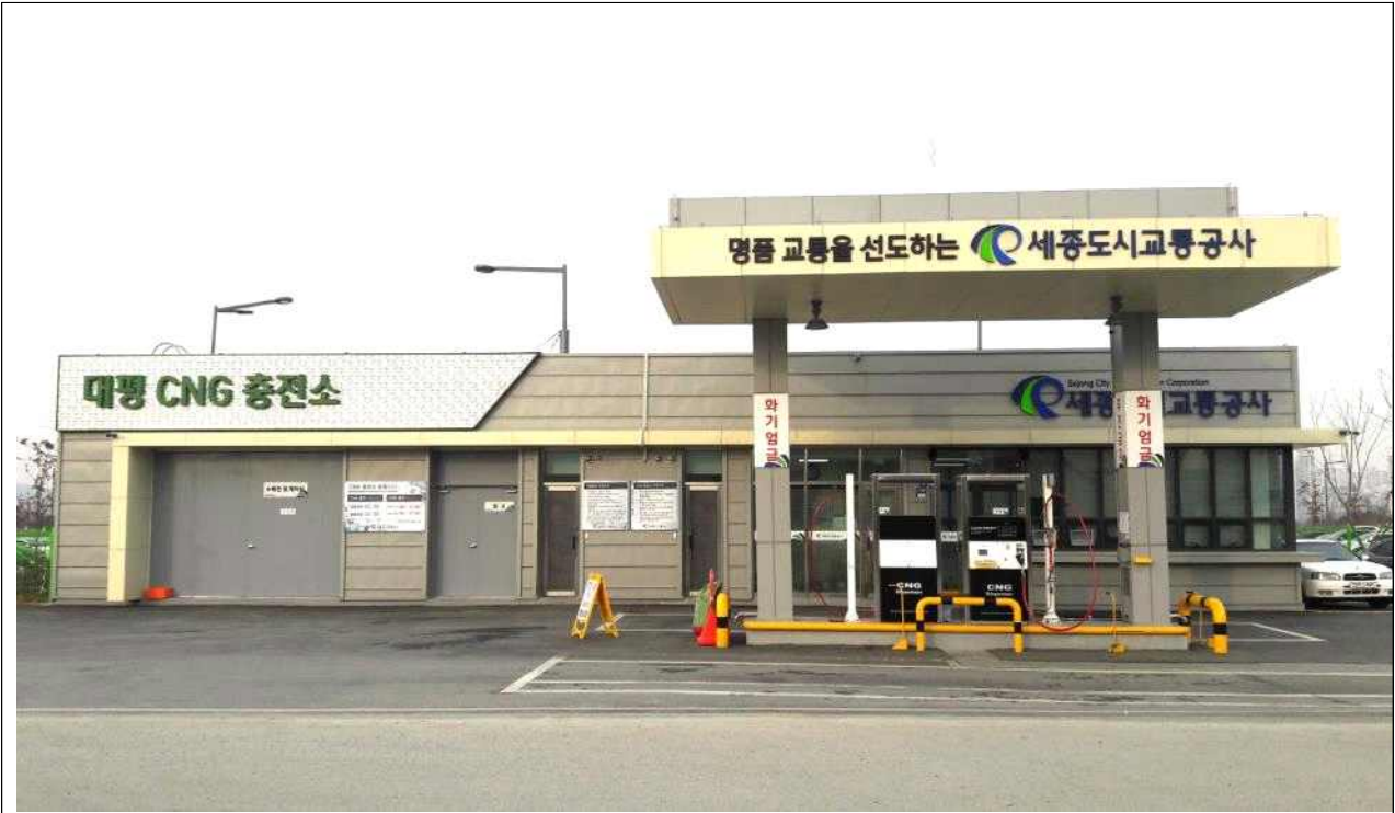
대평 CNG 충전소 전경
